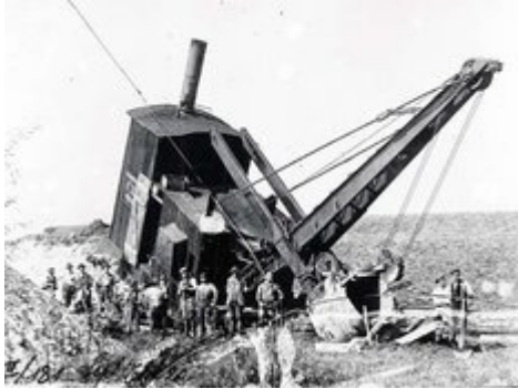
© Innwerk1600 Aufnahmen gibt es vom Kanalbau, die
